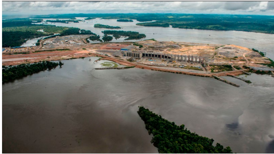
Hidroeléctrica de Belo Monte, en Brasil. Fuente de imagen: Fábio Nascimento/Greenpeace 52
